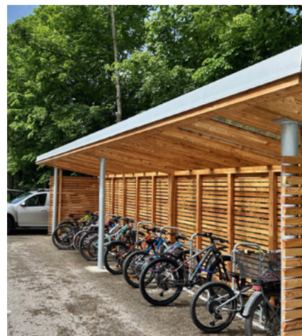
Die neue Fahrradabstellanlage zwischen Schule und Neuem Friedhof.
