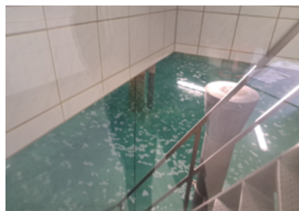
Blick von oben in das Sammelbecken.
