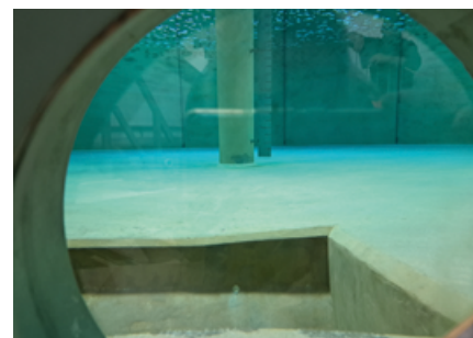
Blick in ein Sammelbecken des Hochbehälters Steinberg.
