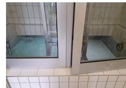
Sammelbecken des Hochbehälters St. Quirin.
